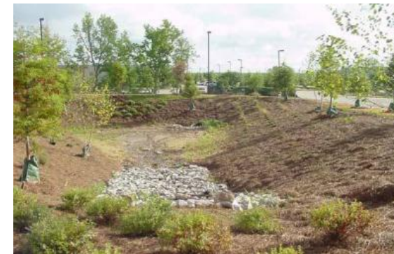
3.- Superficie área impermeable a drenar /área del sistema de biorretención 5:1
