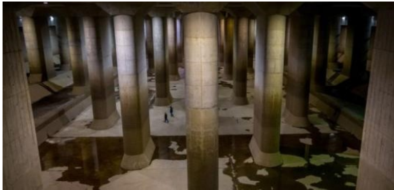
Tokio. Tanque de agua subterráneo más grande del mundo (almacenar casi 350 millones de litros de agua). Protege de inundaciones. Bypass al río Edo.
