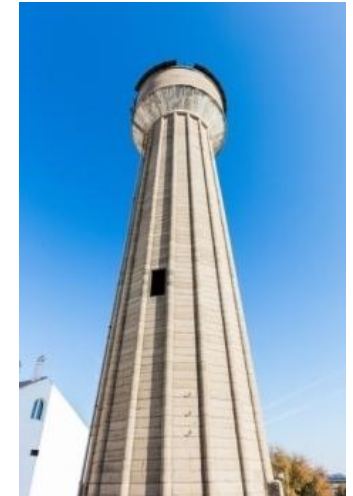
Santiponce (Sevilla) Tanque de agua elevado
